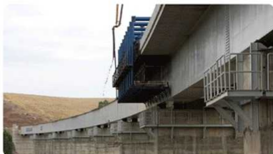
پل دره‌ای ورنکش راه آهن میانه - تبریز
